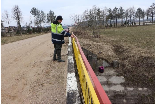
21 pav. Deformuoti plieninių turėklų elementai
