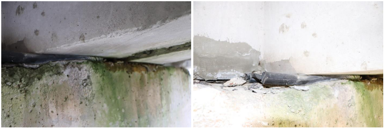
6 pav. Guminiai intarpai perdangų atraminėse zonose
