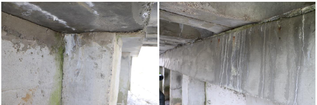
19 pav. Dėl neįrengtų deformacinių pjūvių drėkinami perdangos ir atramų elementai
