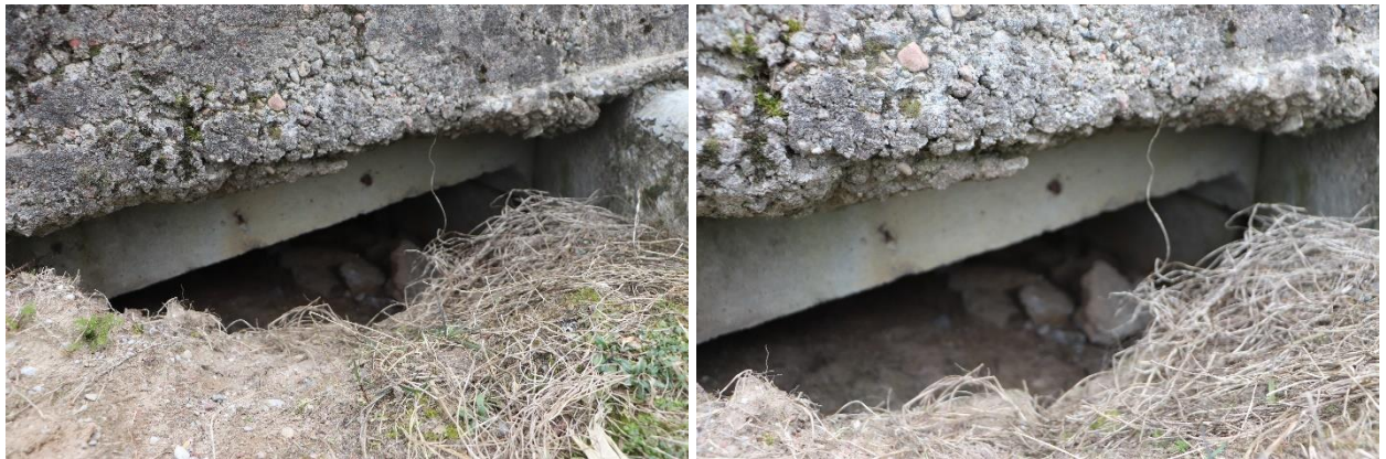
26 pav. Išplautas pagrindas po pereinamomis plokštėmis ties atrama 2
