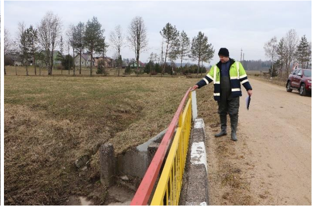
21 pav. Deformuoti plieninių turėklų elementai
