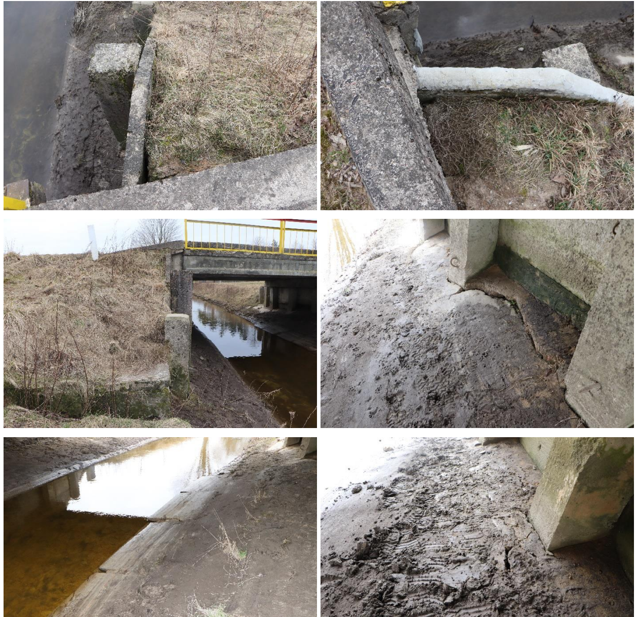
27 pav. Kūgių prietilčiuose ir po tiltu defektai: išplautos kūgių zonose ties atramomis, apaugę kūgių šlaitai, deformuoti ir dumblu apnešti kūgių šlaitus stiprinančios gelžbetoninės plokštės
