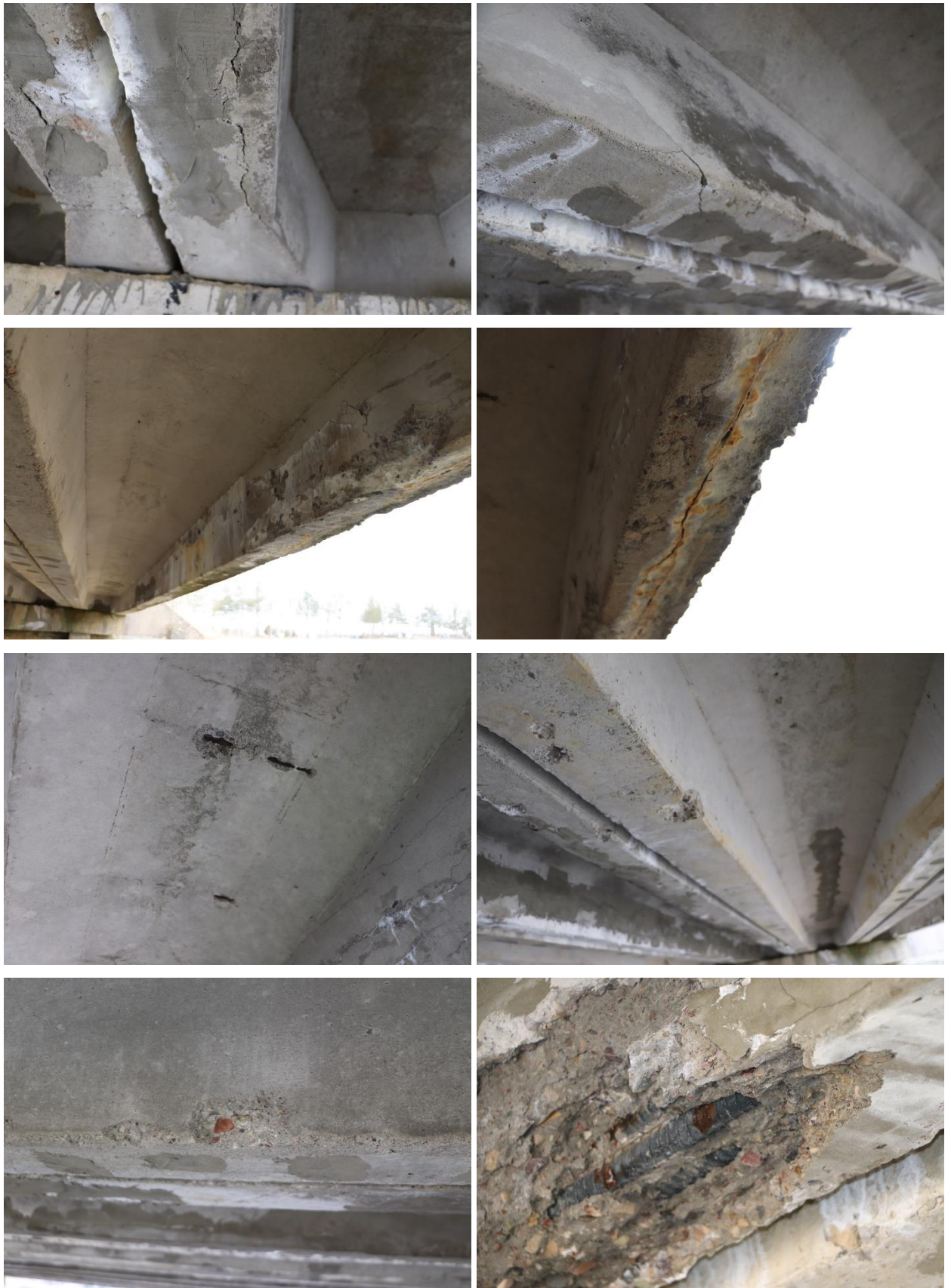
21 pav. tęsinys. Gelžbetoninių perdangos plokščių defektai: betono korozija, armatūros korozijos sukelti išilginiai, apsauginio sluoksnio defektai ir nuoskėlos lokaliuose zonose, porėto betono sluoksniai, prasidėjusi išilginės armatūros korozija
