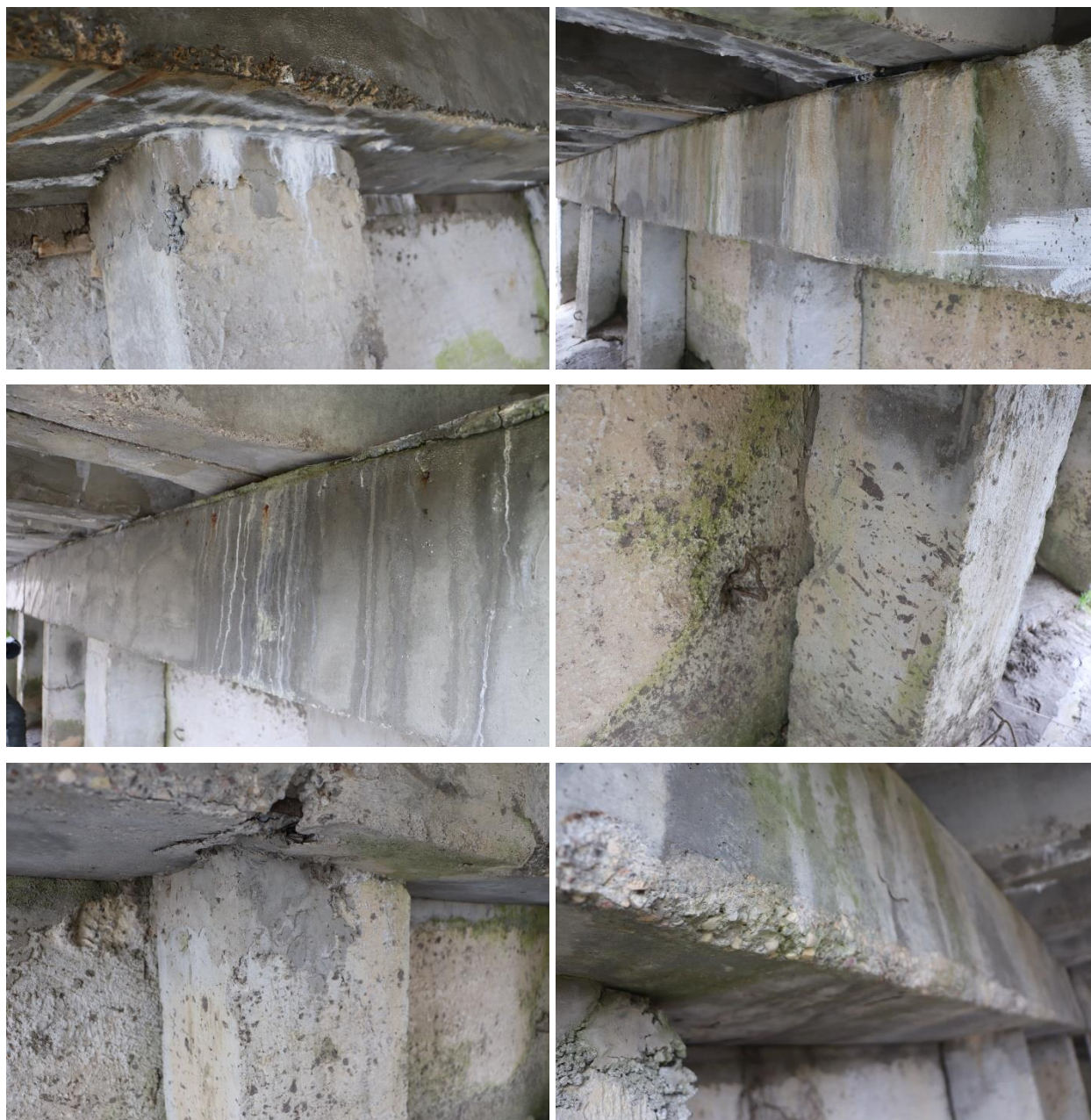
24 pav. tęsinys. Charakteringi ramtų defektai: pratekėjimai, nuoskėlos, nekokybiškai įrengtos rygelio sandūros, sudūlėję ir porėti betono paviršiai
