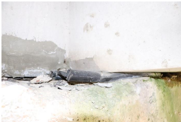
23 pav. Guminiai intarpai tarp perdangų atraminėse zonose
