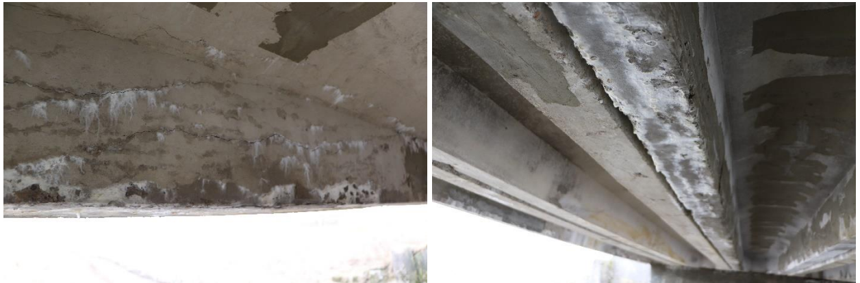
18 pav. Dėl blogos hidroizoliacijos perdangos lokaliuose zonose matomos vandens pratakos bei jų sukelta gelžbetoninių plokščių betono ir armatūros korozija
