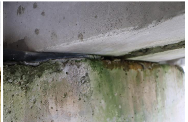
23 pav. Guminiai intarpai tarp perdangų atraminėse zonose
