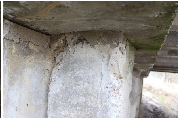
24 pav. Charakteringi ramtų defektai: suremontuoti paviršiai, pratekėjimai, nuoskėlos
