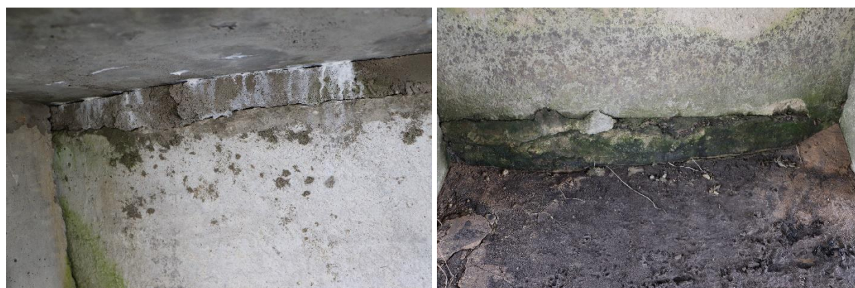
25 pav. Charakteringi ramtų atraminių sienų defektai: plyšiai sandūrose
