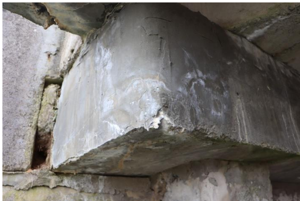
24 pav. Charakteringi ramtų defektai: suremontuoti paviršiai, pratekėjimai, nuoskėlos
