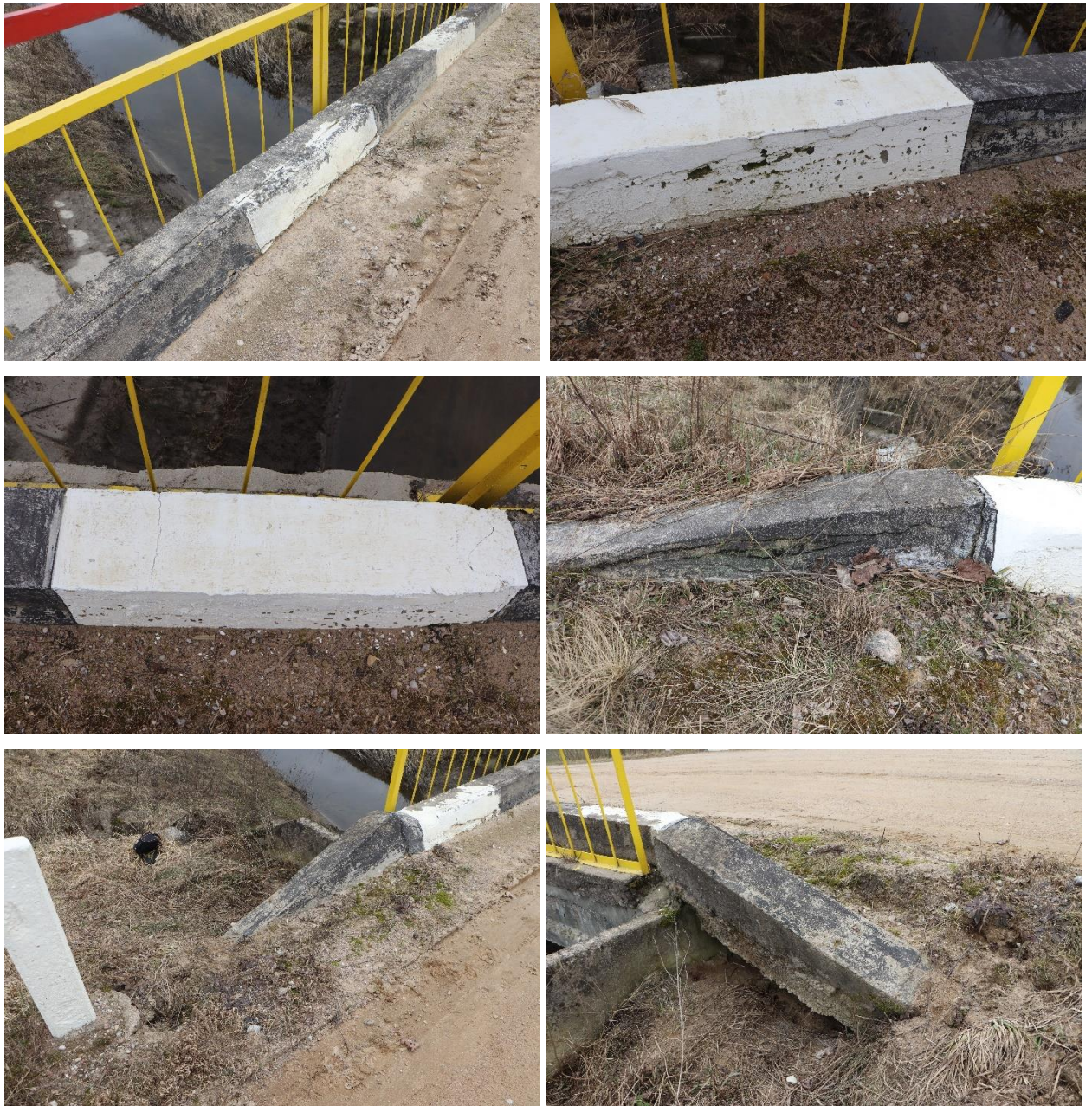
20 pav. Supleišėję, pažeisti ir deformuoti gelžbetoniniai barjeriniai atitvarai
