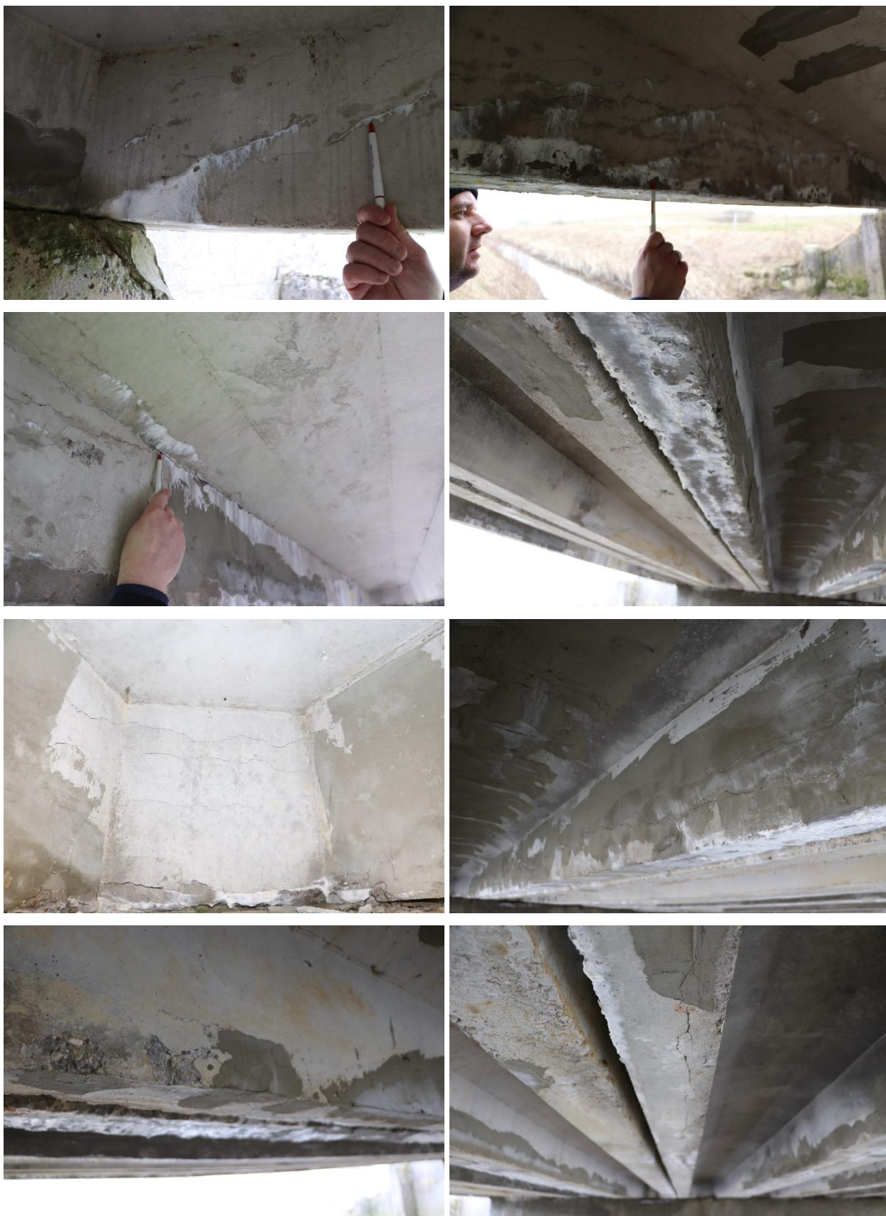
21 pav. Gelžbetoninių perdangos plokščių defektai: betono korozija, išilginiai ir įstrižieji plyšiai, remontinių mišinių pažaidos
